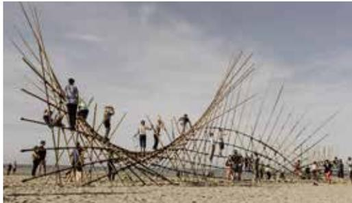
Construction participative d'une archi-structure en bambou à grimper, entre performance et chantier participatif. Sous les gestes des constructeurs, apparaît une structure éphémère faite de cannes de bambous.
